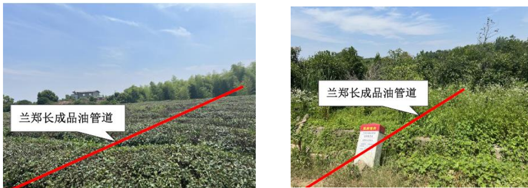
图 2.1-2 兰郑长成品油管道与咸宁国际陆港物流园交叉工程现状图
